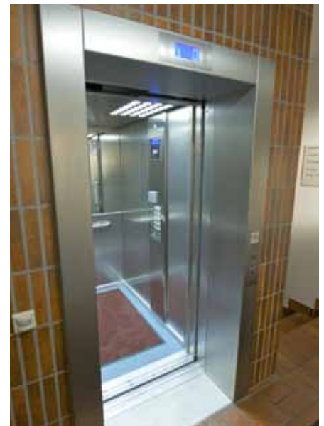
Größer und für Menschen mit eingeschränkter Bewegungsmöglichkeit leichter nutzbar: Der neue Aufzug.
