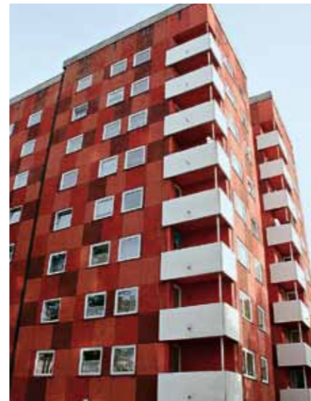
Ein Beispiel für die Modernisierungen, die wir 2010 vorhaben: Nürnberg-Eibach, Schussleitenweg 2. Außen erhält diese Wohnanlage ein „frisches Gesicht“.
