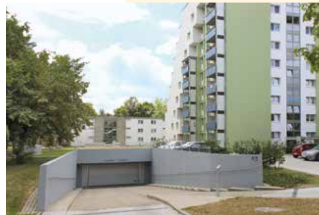
Tiefgarage, PKW-Stellplätze in Ingolstadt, Waldeysenstraße 41
